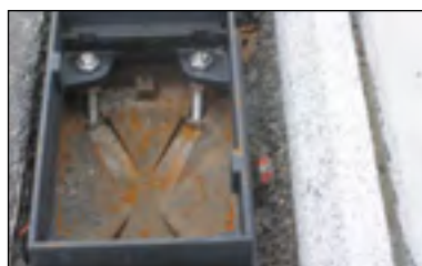
joint entre bordure granit et grille
