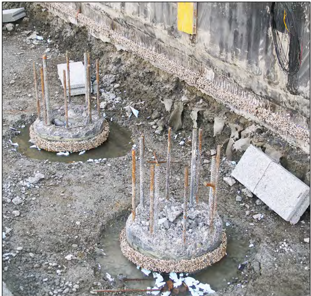
Les bandes BFL-Mastix assurent l'étanchéité de l'ouvrage en agissant comme une barrière au passage de l'eau entre les pieux et le radier.
