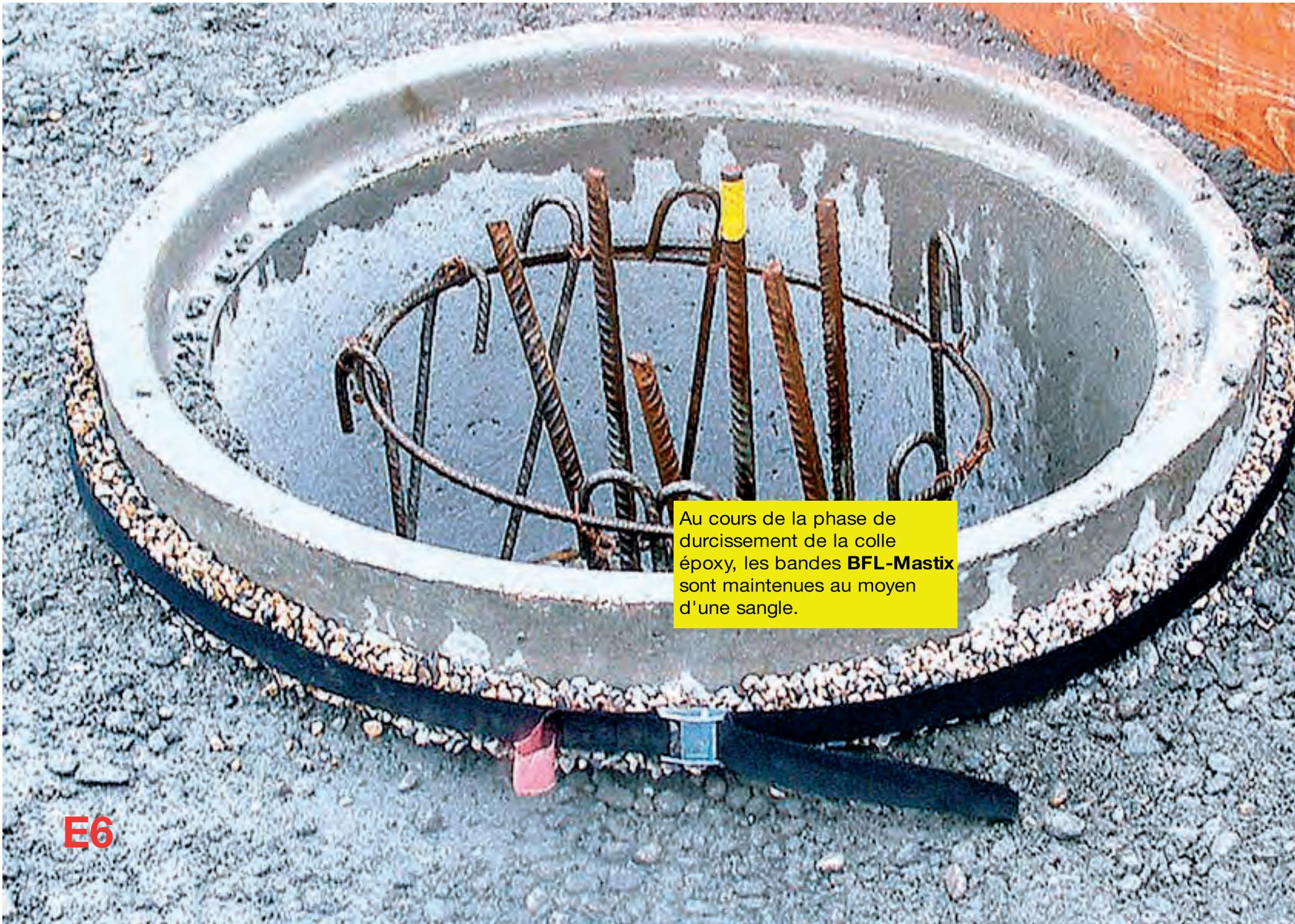
Au cours de la phase de durcissement de la colle époxy, les bandes **BFL-Mastix** sont maintenues au moyen d'une sangle.
