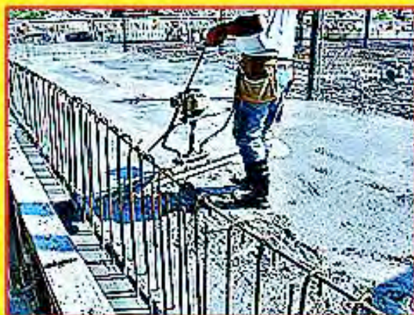
Vibration après l'incorporation
