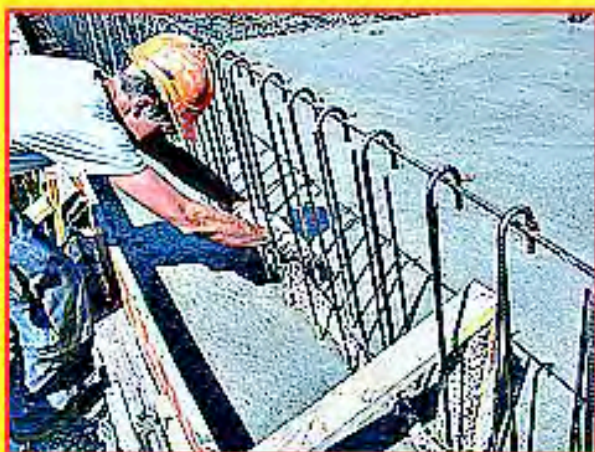
Incorporation des bandes BFL-Mastix
