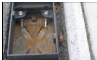
Fuge zwischen Bordstein aus Granit und Ablaufgitter
