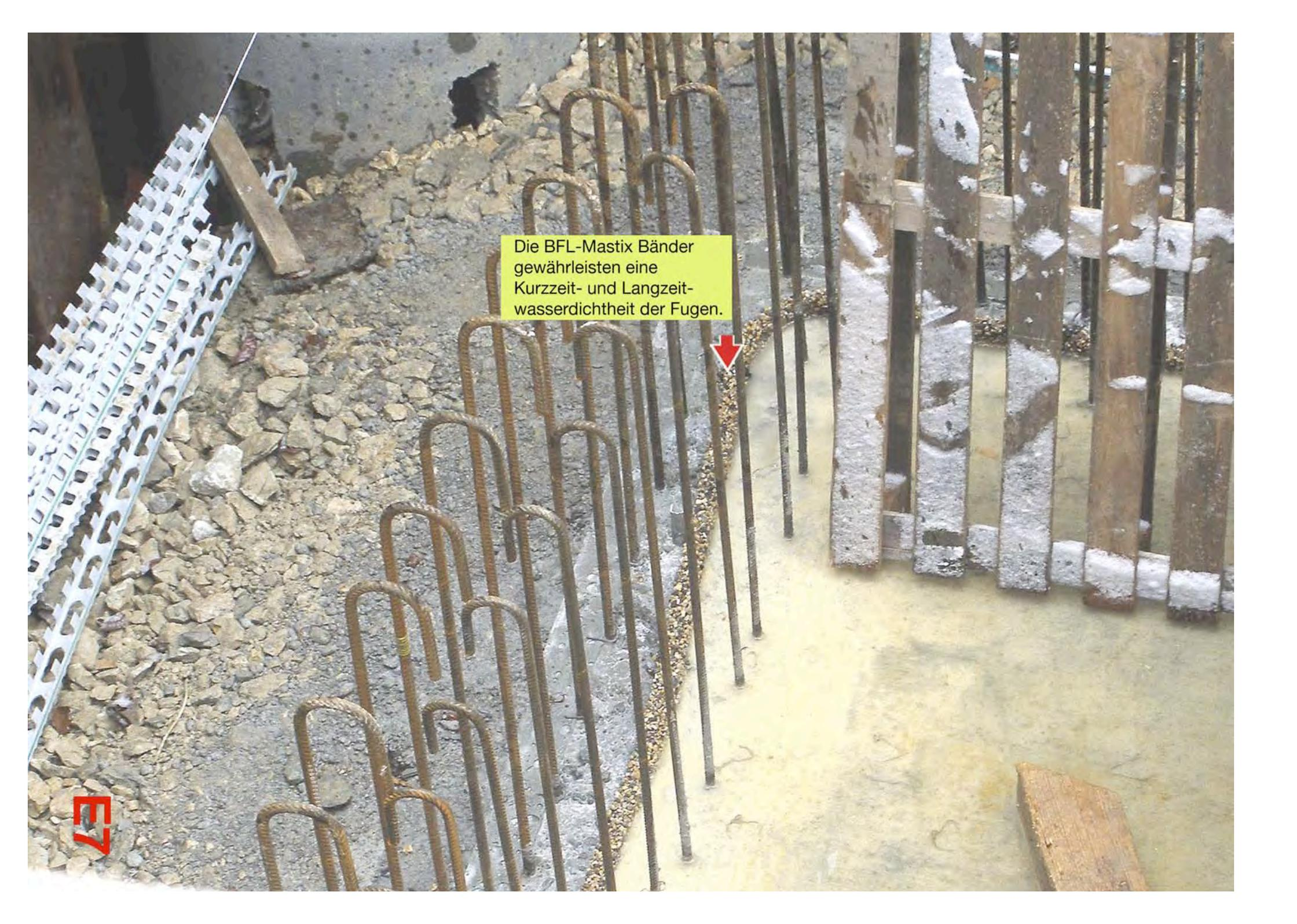
Die BFL-Mastix Bänder gewährleisten eine Kurzzeit- und Langzeitwasserdichtheit der Fugen.
