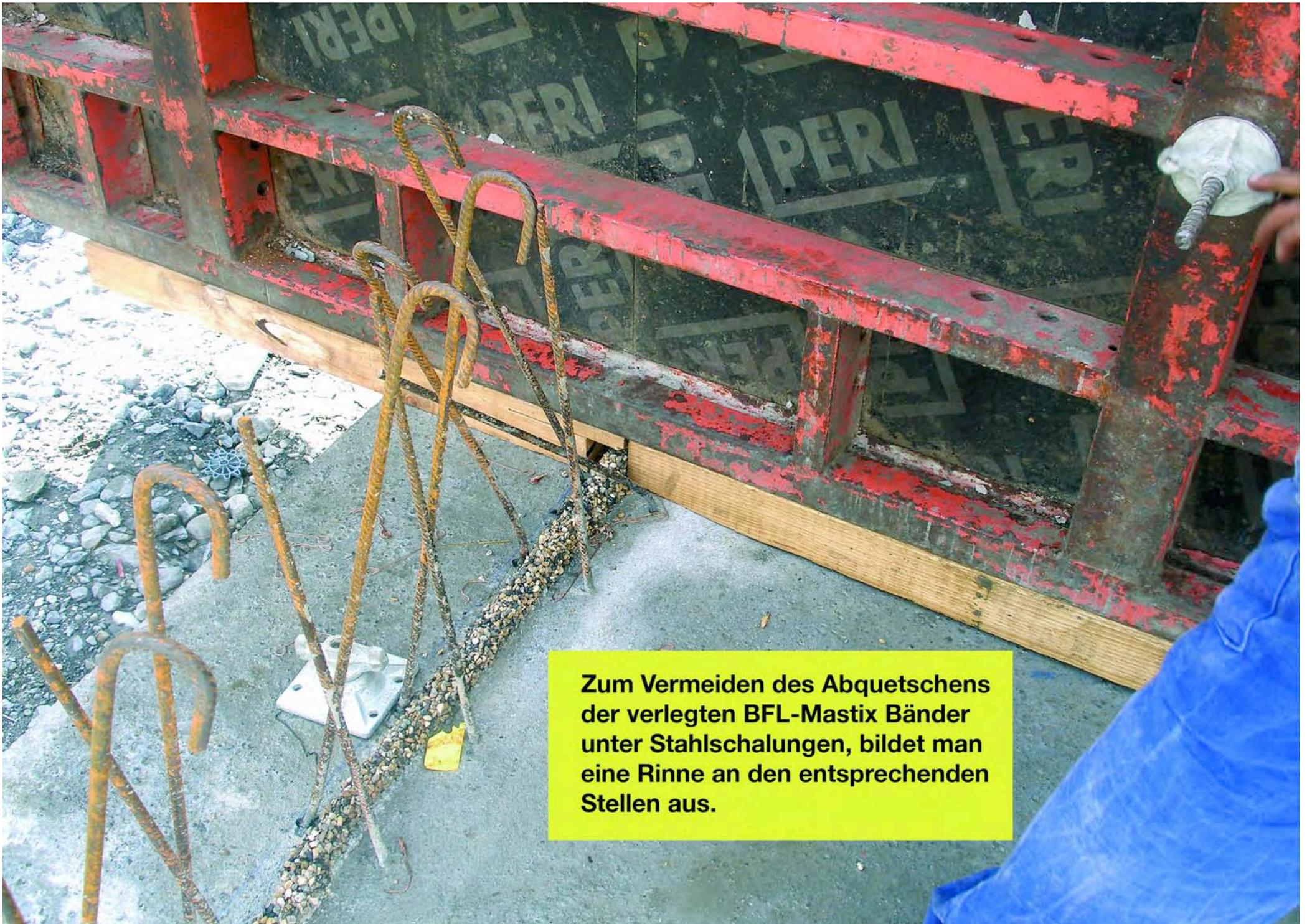
**Zum Vermeiden des Abquetschens der verlegten BFL-Mastix Bänder unter Stahlschalungen, bildet man eine Rinne an den entsprechenden Stellen aus.**
