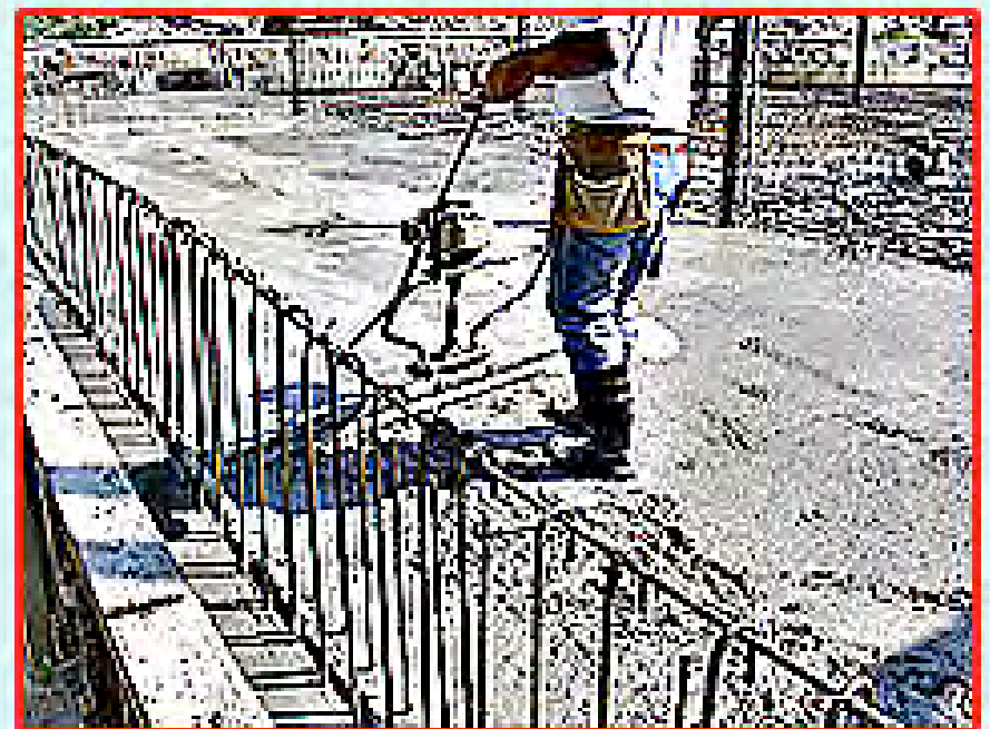
Vibrieren nach dem Bandverlegen
