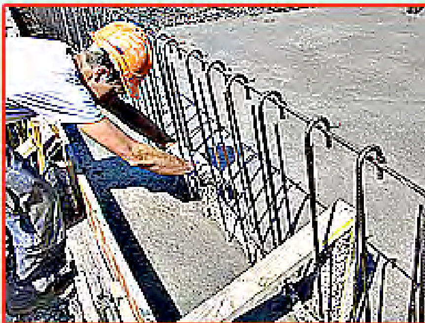
Einlegen der BFL-Mastix Fugenbänder
