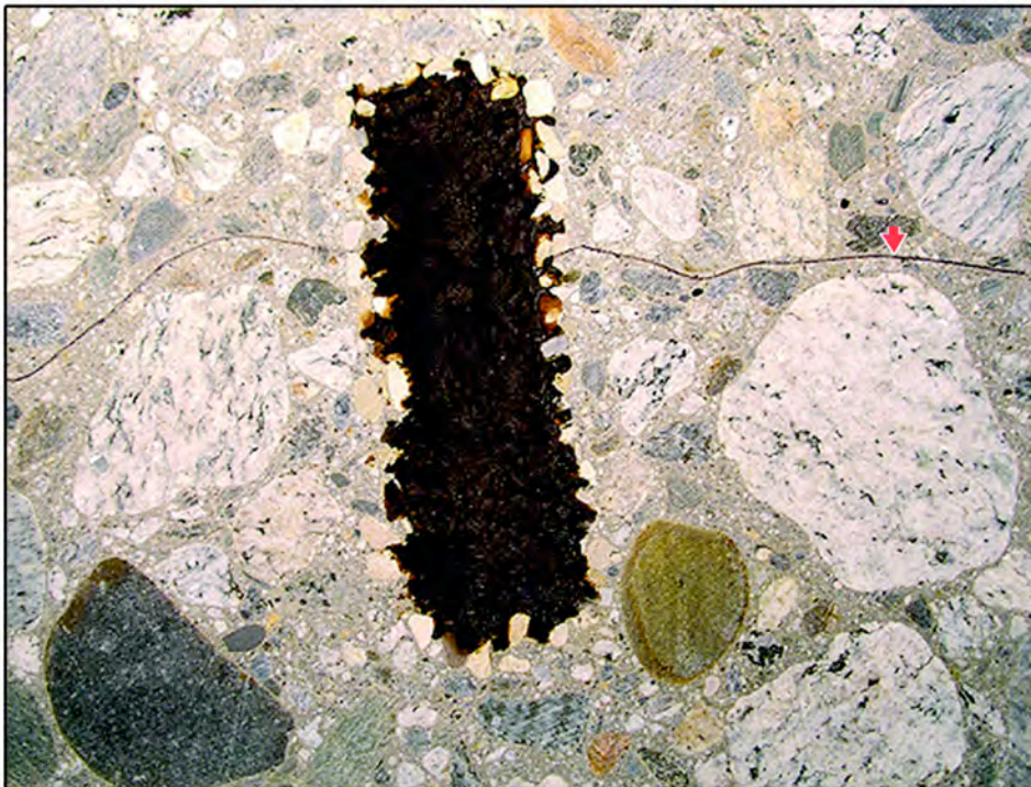
Riss in einer Arbeitsfuge
