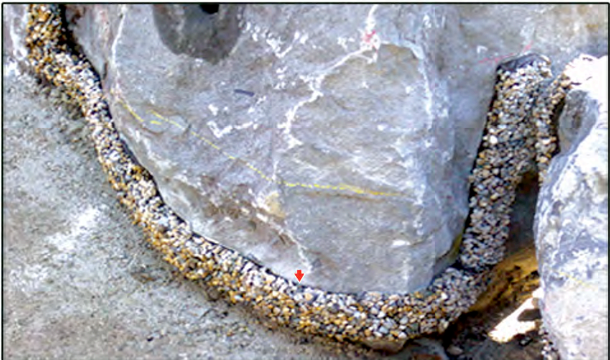
BFL-Mastix Bänder bei chemischer Verklebung auf Fels.
