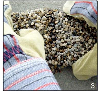
Le raccord entre deux bandes s'effectue en chauffant légèrement les extrémités et en les pressant durant trois secondes.
