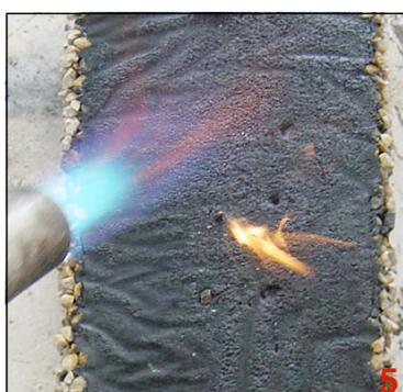
Flammer légèrement la bande et l'appliquer sur le béton en exerçant une pression.
