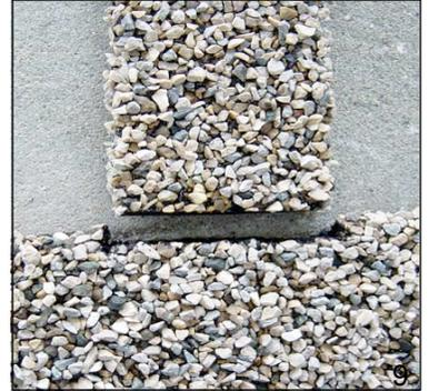
Pour raccorder perpendiculairement deux bandes gravillonnées, on utilise une spatule chauffée pour effectuer une encoche (9). On enlèvera à cet effet la peau de gravillons sur une largeur correspondant à la bande à raccorder (8).
