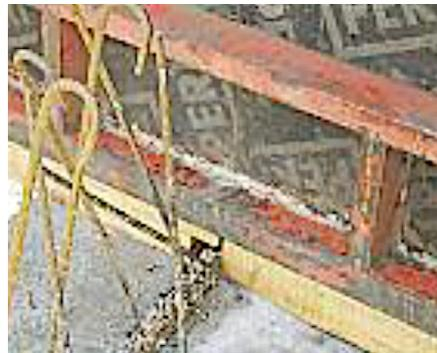
Das Waschen der Betonierfuge geschieht vor dem Versetzen der Schalplatten. Die Oberfläche der Betonierfuge wird im Sommer bei Wind stark eingenässt, um eine poröse Zone durch Wasserabsaugen aus dem frischen Beton durch den trockenen Beton der Bodenplatte zu vermeiden.
