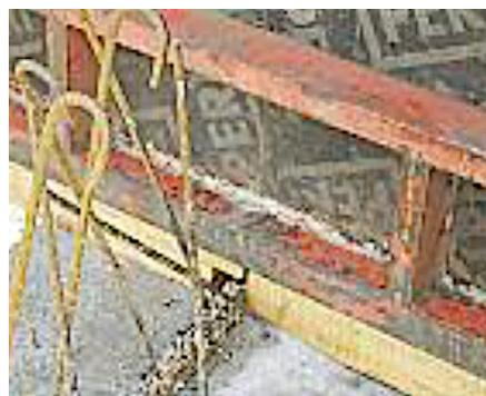
Le lavage de la surface de la reprise de bétonnage s'effectue avant la pose du coffrage. La surface de reprise de bétonnage est saturée d'eau en été et lorsqu'il y a du vent pour éviter la formation d'une zone poreuse par absorption de l'eau du béton frais par le béton sec du radier.
