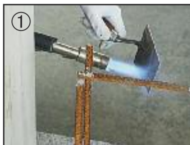
Vorbereitung einer Eckverbindung
