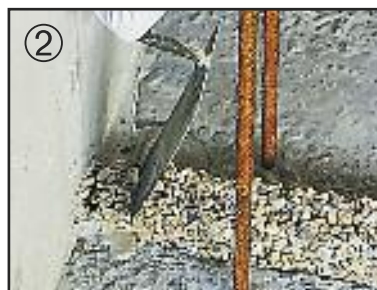
Vorbereitung einer Eckverbindung
