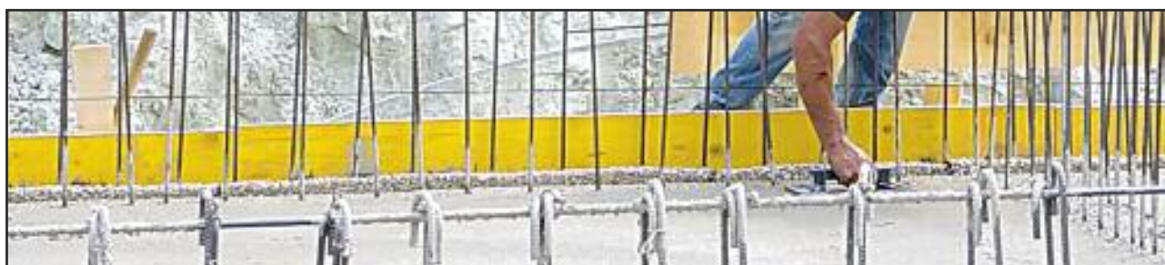
Verlegte Bänder in Wartestellung
