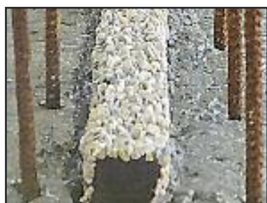
Verlegen in frischen Beton
