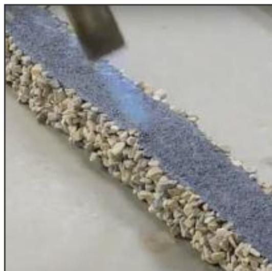
**2** En hiver, il est nécessaire de flammer légèrement la surface de collage.
