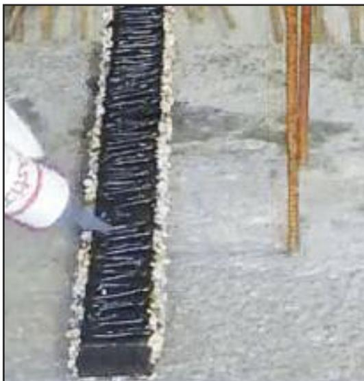
**1** La colle Mastix MS-Polymer est appliquée sur la face non recouverte de gravillons.
