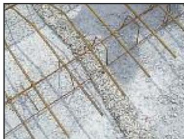
Bandes type R collées sur béton de propreté
