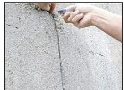
Travaux d'entretien sur les joints verticaux d'un barrage avec bandes type N
