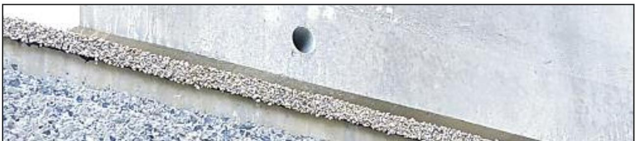
Bandes type R collées horizontalement sur un mur
