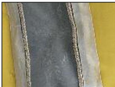
Bandes type R collées sur PVC pour l'étanchéité des reprises de bétonnage dans un tunnel
