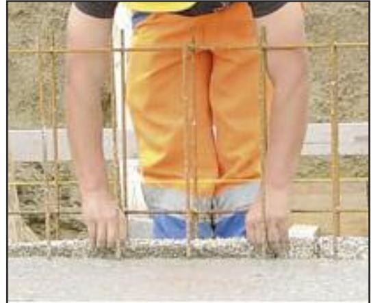
**1** Les bandes BFL-Mastix type R4 sont incorporées dans le béton frais pendant ou après le bétonnage d'un radier, **selon la consistance du béton.**
