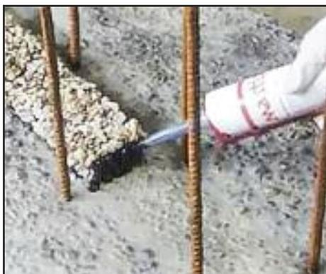
**3** Les raccords entre les bandes s'effectuent avec la colle Mastix MS-Polymer en veillant à ce qu'elle ne déborde pas sur les gravillons lors de l'assemblage des bandes.
