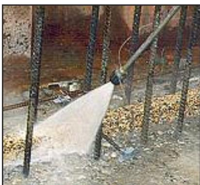
**Le lavage de la surface de la reprise de bétonnage s'effectue avant la pose du coffrage.**
