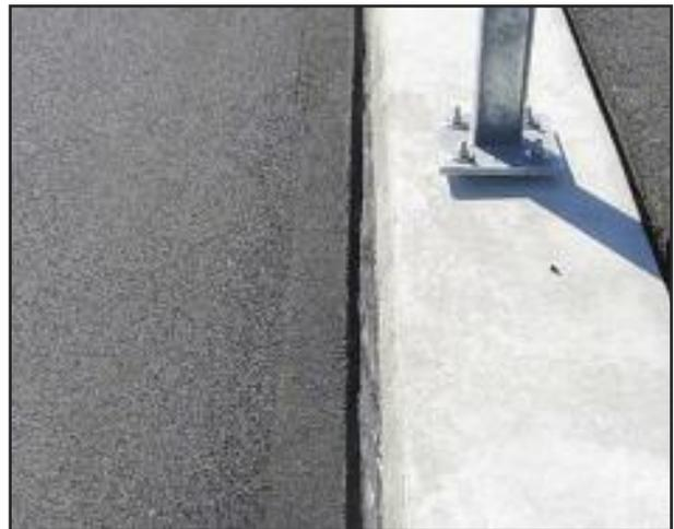
Exécution d'un joint de bordure sur un pont pour éviter la pénétration des eaux salées dans le tablier
