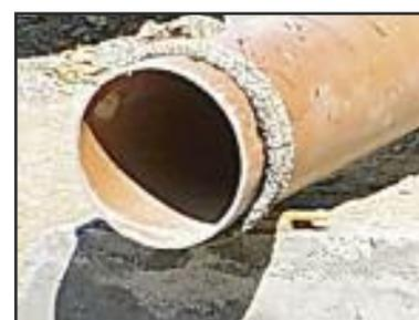
Bandes type R collées sur tuyaux en PVC (voir vidéo sur [www.mastix.ch](http://www.mastix.ch))
