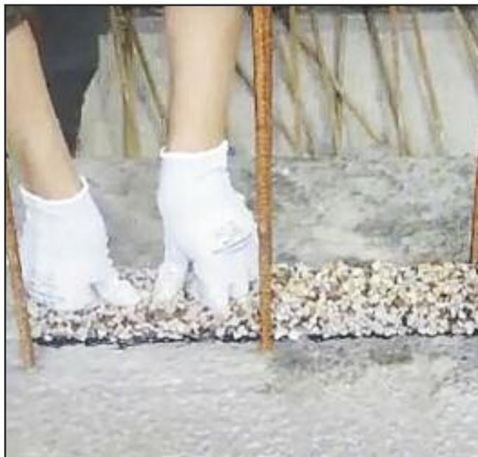
**2** Une pression est exercée sur les bandes lors de la pose sur la surface de collage.
