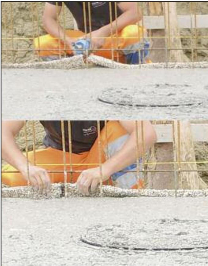
**2** Les raccords entre les **bandes** s'effectuent en chauffant les extrémités avec un petit chalumeau à propane durant quelques secondes.
