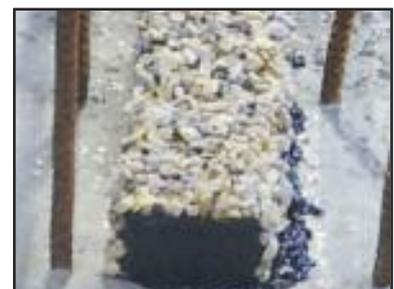
Collage d'une bande type R avec la colle Mastix MS-Polymer
