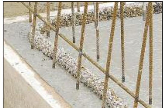
**3** Les bandes BFL-Mastix type R4 sont incorporées dans le béton frais, **la moitié dans le béton, l'autre en attente.**
