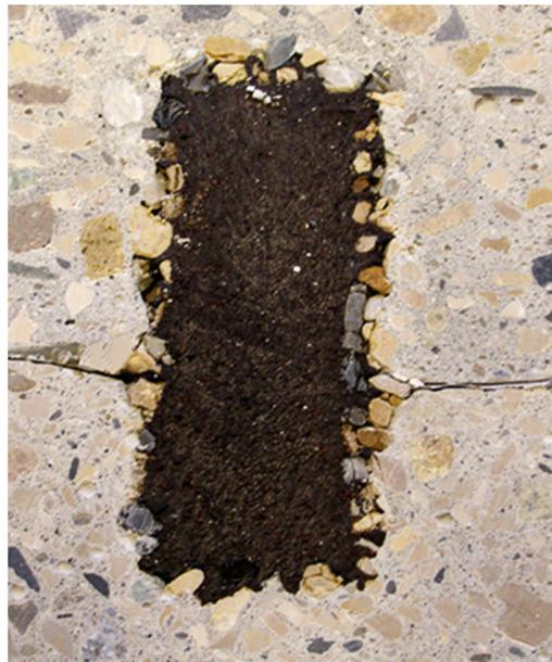
La pâte de ciment assure la liaison parfaite entre les granulats constitutifs de la bande BFL-Mastix et ceux du béton en place garantissant la continuité de l'ensemble, et donc son étanchéité.
