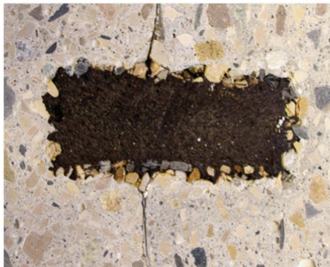
C'est grâce à la pâte de ciment que le béton se lie aux gravillons des bandes BFL-Mastix
